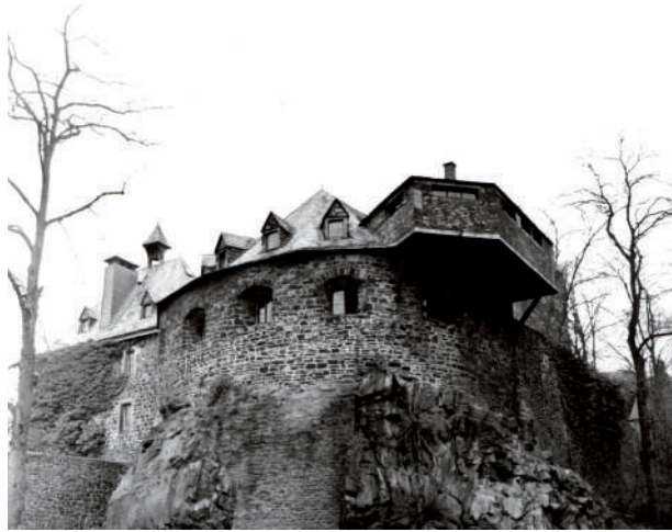
Die Jugendherberge im unteren Hof der Burg Altena, Ansicht vom Parkplatz außerhalb, Kat.-Nr. 63
