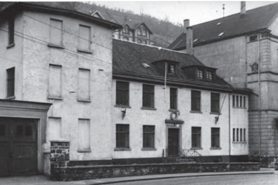
Die Netter Schule in Altena, Kat.-Nr. 59
